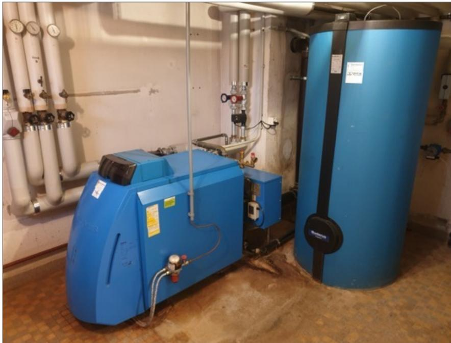
Abb.: Ölheizung mit Warmwasserboiler (ca. 800 l)
