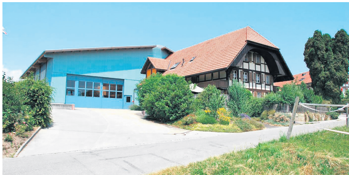
Der Wärmebedarf des Hausteils im Vordergrund wird dank der Modernisierung rund einen Drittel sinken.
