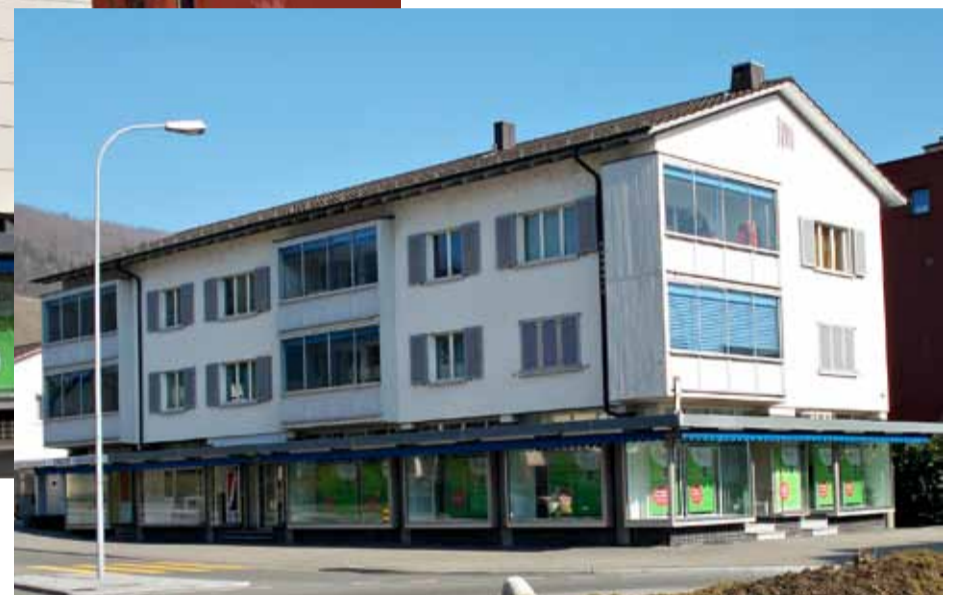
Das Mehrfamilienhaus in Wettingen an der Landstrasse 49 vor der Sanierung.
