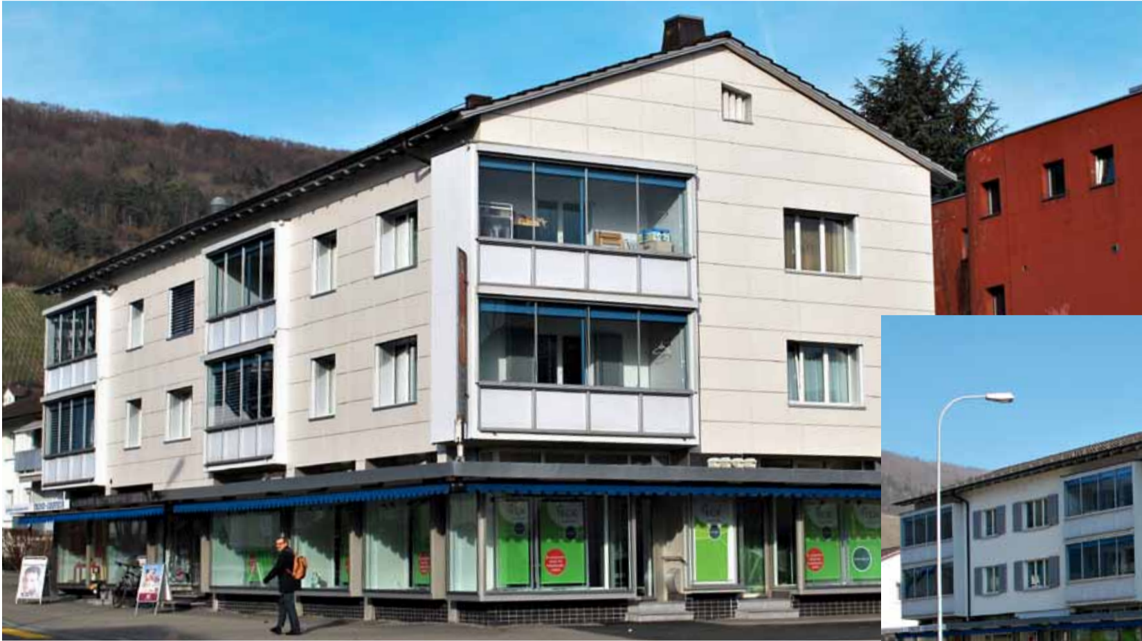
Das Haus nach der Sanierung – frisch eingepackt in 18cm Mineraldämmung und Keramikplatten. Die Fensterläden wurden durch Storen ersetzt.
