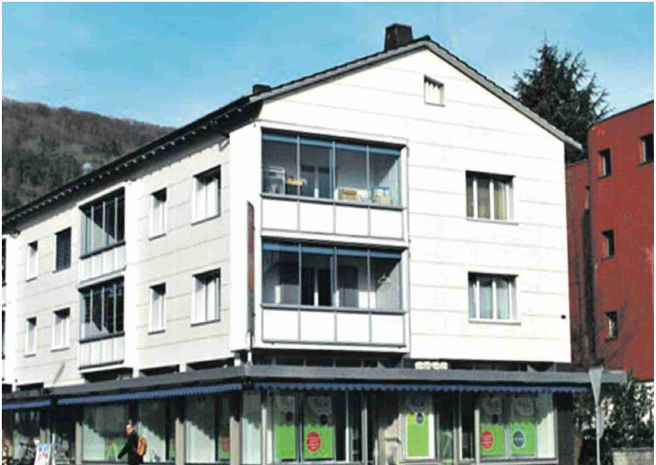
Das Haus nach der Sanierung – frisch eingepackt in 18 cm Mineralfällung und Keramikplatten. Die Fensterläden wurden durch Storen ersetzt
