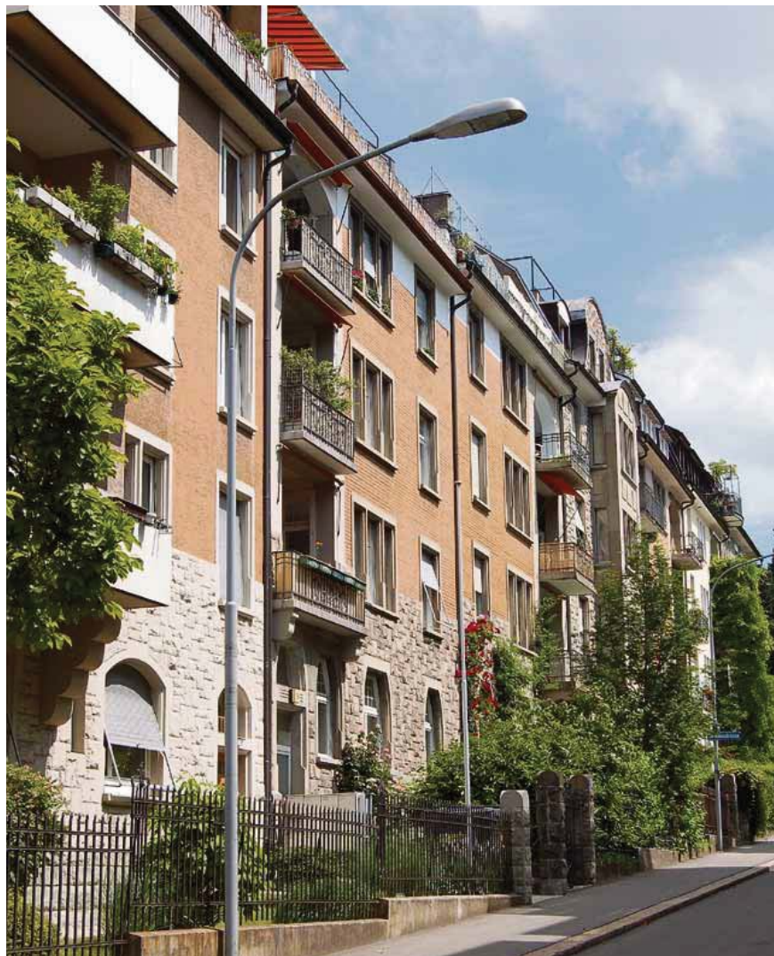
Immer mehr Eigentümer sind daran interessiert, den energetischen Zustand ihrer Liegenschaft zu dokumentieren. BILD HEV
